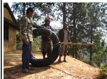
Verlegen zusätzlicher Wasserleitungen
